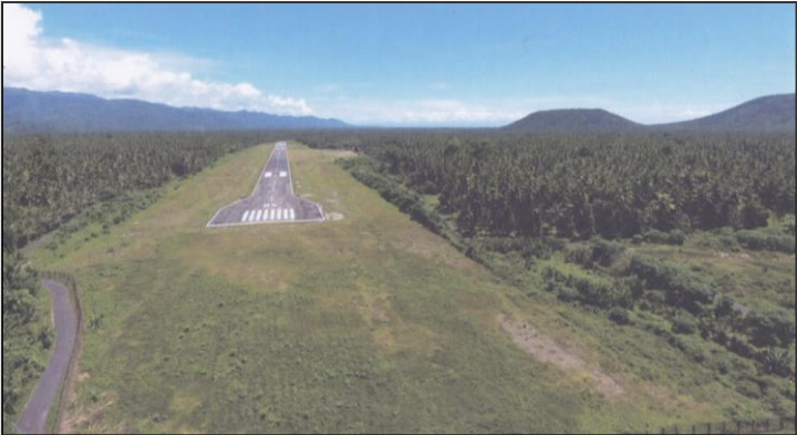
Gambar 2. Bandara Gamar Malamo Dari Sisi Udara
